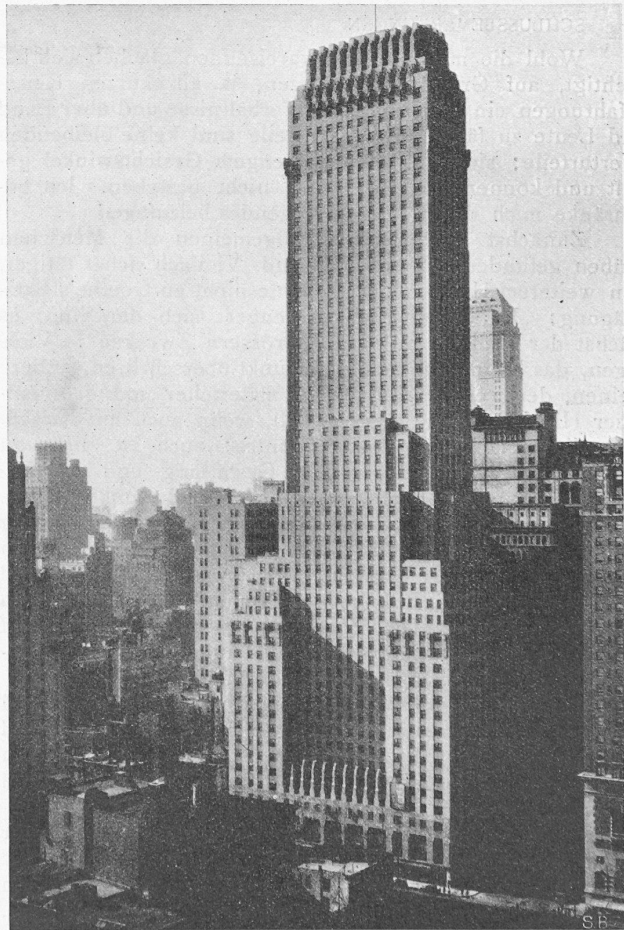
Abb. 71. Chanin Building, 207 m hoch, an der Lexington Avenue. Rechts die Ecke des Commodore Hotels beim Grand Central Bahnhof.
