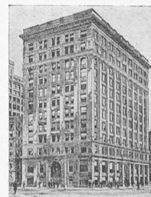
Abb. 69. Erstes Stahlskelett-Hochhaus, erbaut 1884. (Masstab wie Abb. 70).
