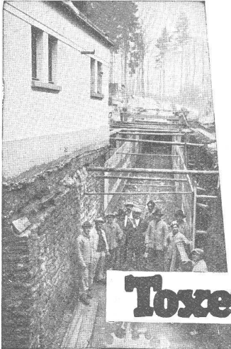
Unterirdische Transport- und Fernheizungskanäle Kantons- spital Neubau, Luzern. Bauleitung: Büro des Kan- tonsbaumeisters für Spital- bauten. Unternehmer: J. Pfisterer & Galli Söhne, Luzern.
