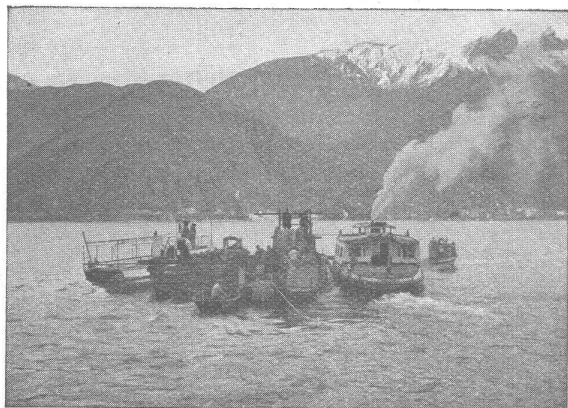
Abfahrt der Verlegeflotte in Poiana
