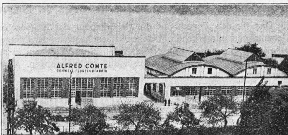
Flugzeugfabrik in Horgen 1700 m 2 Bitumitekt-Bedachungen grünschiefer-besandet
