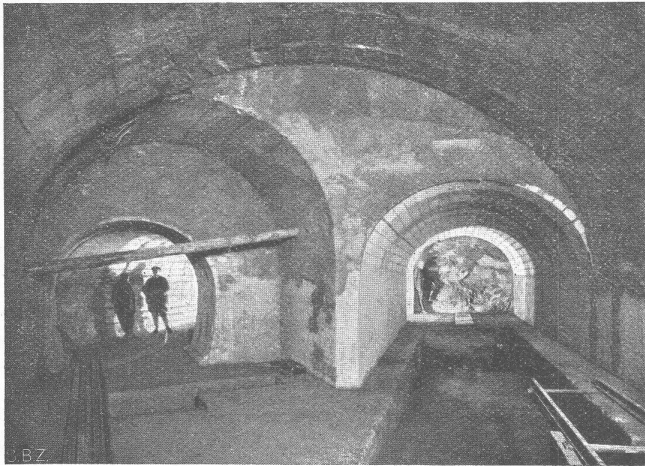
Stollenbau - System Bauschäfer - ausgeführt für die Zementwerke A.-G. Hausen b. Brugg.
