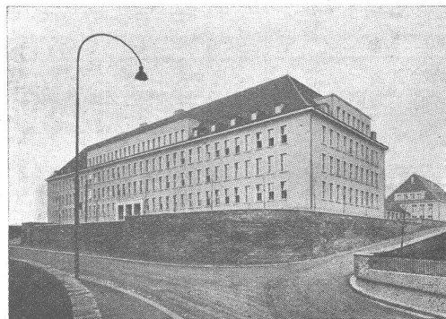
Schulhaus Milchbuck. Arch. Alb. Froelich
