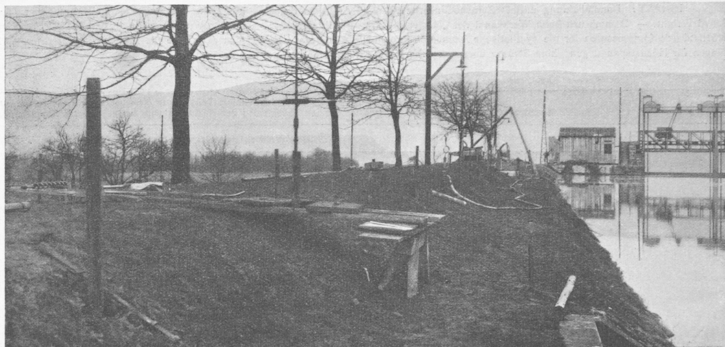
Abb. 4. Ueberblick der Dichtungsstrecke, flussabwärts gesehen.
