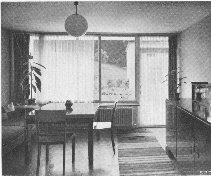
Abb. 25. Wohnraum Typ D. Holzschiefefenster, darunter langer Radiator.
