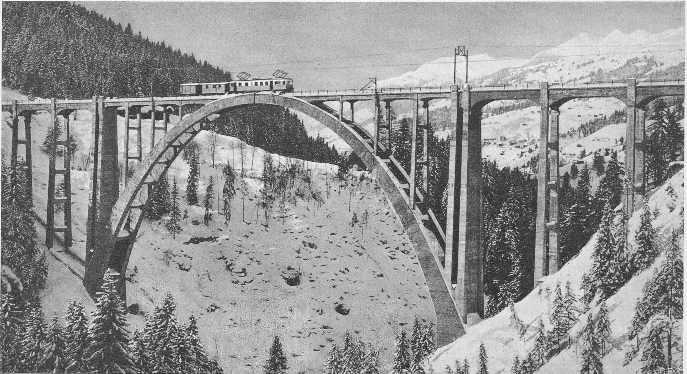
Abb. 1. Eisenbetonbrücke von 100 m Spannweite der Chur-Arosa-Bahn über die Plessur bei Langwies, flussaufwärts gesehen. Erbaut 1912/14 von Ed. Züblin & Cie. A.-G., Zürich, nach eigenem Entwurf.
