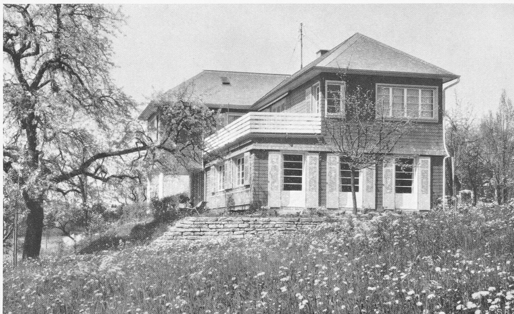
DAS „REBHAUS“ IN ITSCHNACH OB KÜSNACHT-ZÜRICH ARCHITEKTIN LUX GUYER, ZÜRICH
