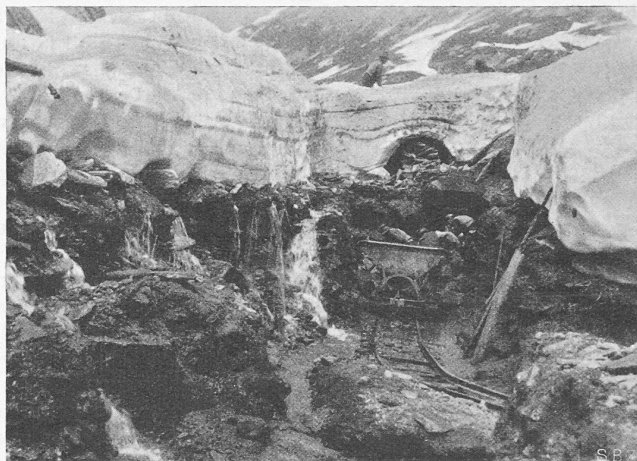
Abb. 5. Aushub des gedeckten Kanals, am 12. Juni 1930.
