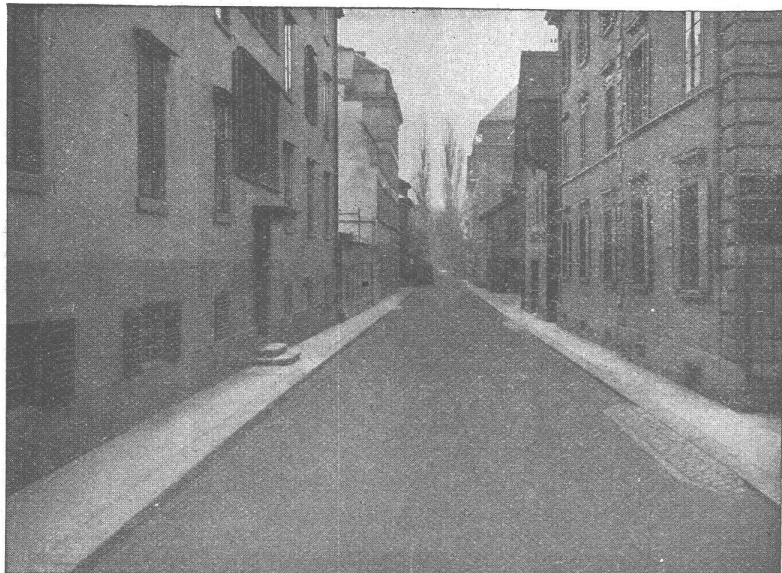
GLARNISCHSTRASSE ZÜRICH Walz-Asphalt: Topeka, 6 cm stark
