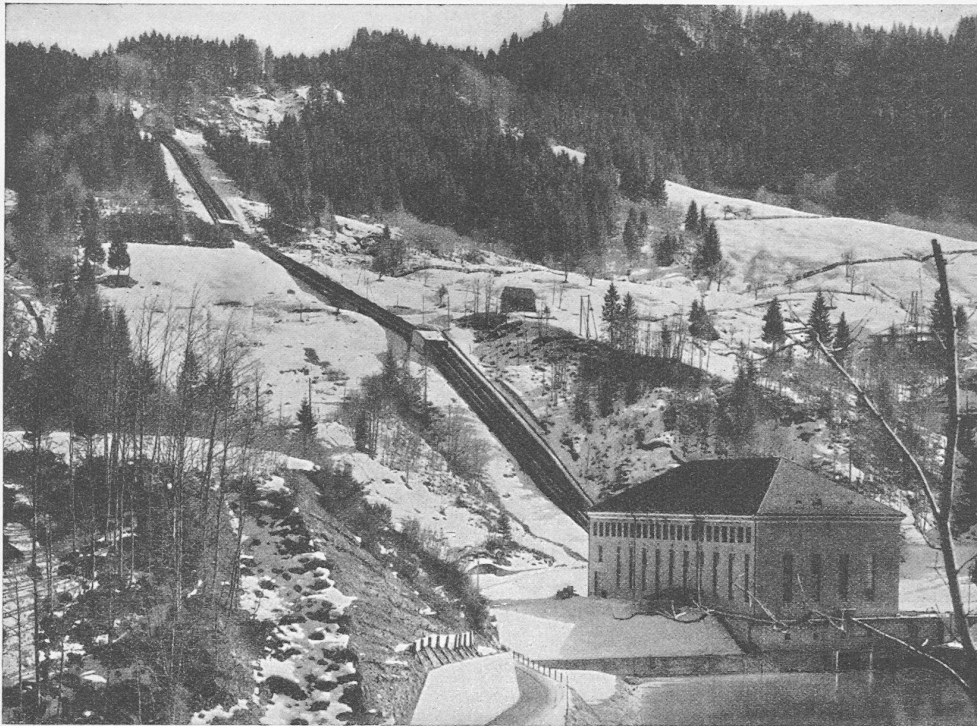
Abb. 32. Druckleitung und Zentrale Rempen, aus Norden gesehen.
