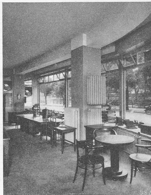
Abb. 5. Innenansicht der Fensterwand im Erdgeschoss.
