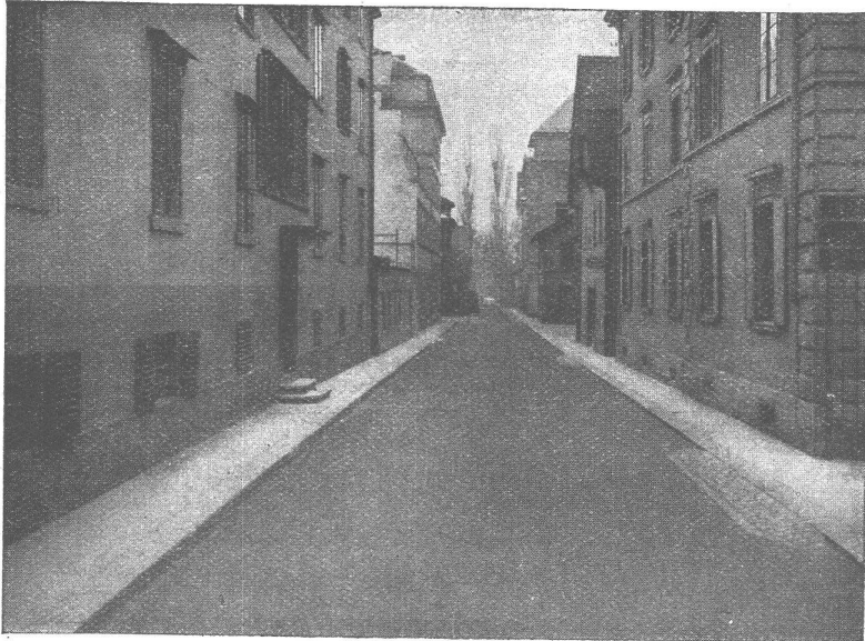
GLARNISCHSTRASSE ZÜRICH Walz-Asphalt: Topeka, 6 cm stark
