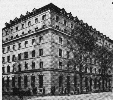
VOLKSBANK ZÜRICH, ARCHITEKTEN HONEGGER & MOSER, ZÜRICH
