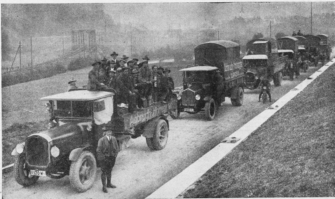
Sieben BERNÄ Kipper, der aus zwölf BERNÄ bestehenden Kolonne für Abbrucharbeiten.
