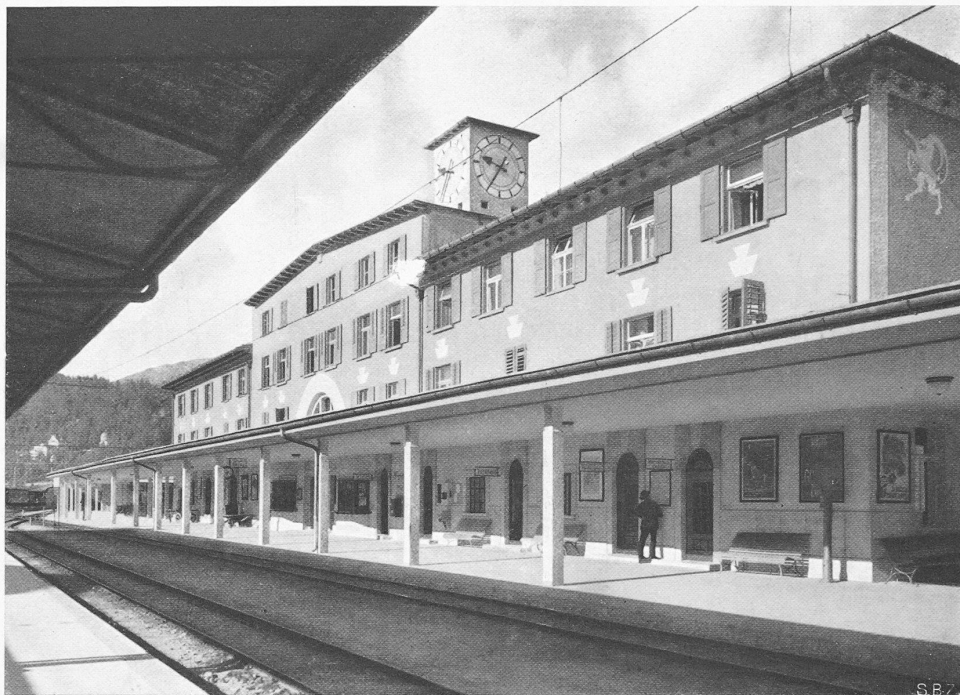
BAHNSTEIGSEITE DES NEUEN BAHNHOFES ST. MORITZ UMGEBAUT DURCH ARCH. NIC. HARTMANN & CIE., ST. MORITZ
