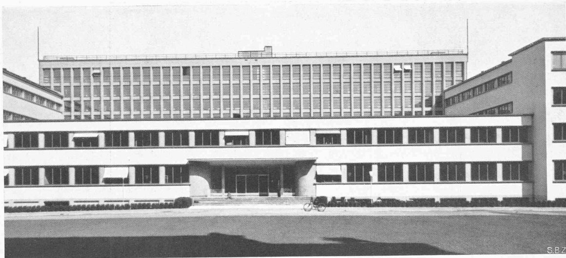
HAUPTTEINGANG IN DER MITTE DER SÜDFRONT, IM HINTERGRUND DAS BÜCHERMAGAZIN
