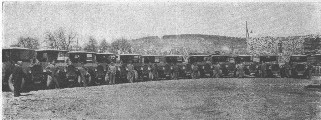
Spezialkolonne für Abbrucharbeiten, bestehend aus 12 BERN A - Dreiseitenkippern
