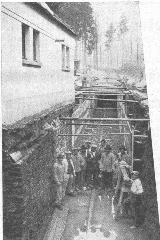
Unterirdische Transport- und FernhelzungsKanäle Kantonsspital - Neubau Luzern. • Bauleitung: Bureau des Kantonsbaumeisters für Spitalbauten. • Unternehmer: J. Pfisterer & Galli Söhne, Luzern.
