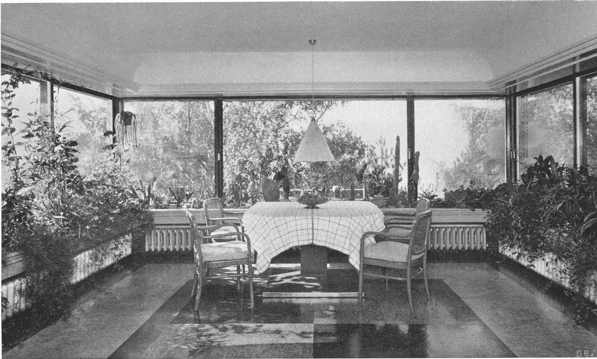
Abb. 20. ESSZIMMER-WINTERGARTEN. BODEN GUMMI, DECKE HELL OELFARBE; EISENRAHMEN DER SPIEGELGLAS-SCHIEBEFENSTER BLAU UND ROT. — BLUMENTROG EISENBETONKONSOLE MIT KERAMIK-VERKLEIDUNG DIREKTE ERDEINFÜLLUNG, WASSERABLAUF IN VERDUNSTUNGSSCHALEN DER HEIZKÖRPER
