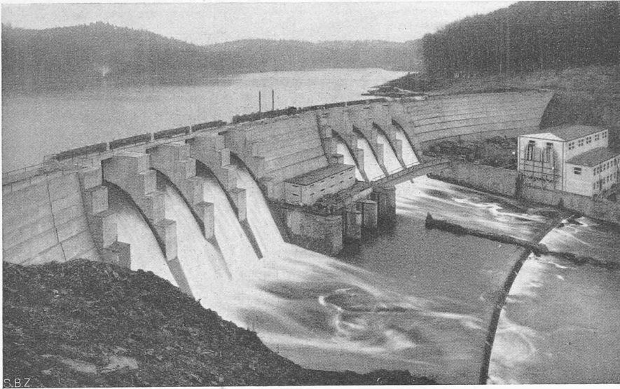
Abb. 4. Ansicht der Talsperre Kriebstein im Zschopautal (Sachsen).
