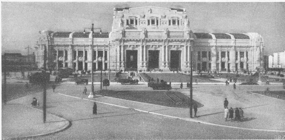
Abb. 3. Die Hauptfront des neuen Mailänder Zentralbahnhofs an der Piazza Andrea Doria. (Phot. Pace & Co., Milano.)
