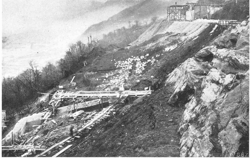
Abb. 34. Blick ostwärts gegen die Strassenüberführung bei Km. 161,5 der Ceneri-Rampe (16. Dez. 1931).
