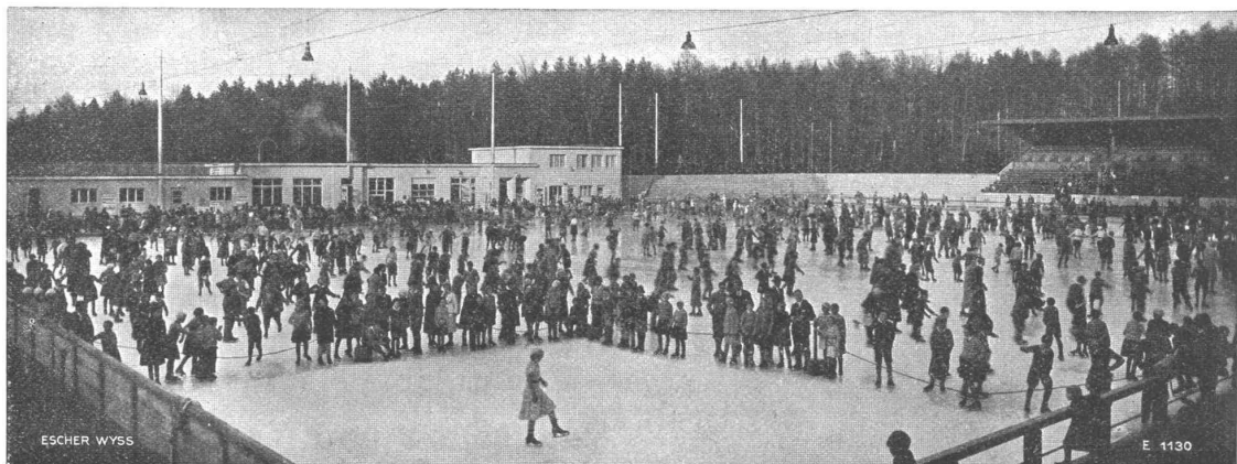
Freiluft-Kunsteisbahn Dolder in Zürich mit einer Eislauffläche von 5600 m 2 , Erweiterung 1932
