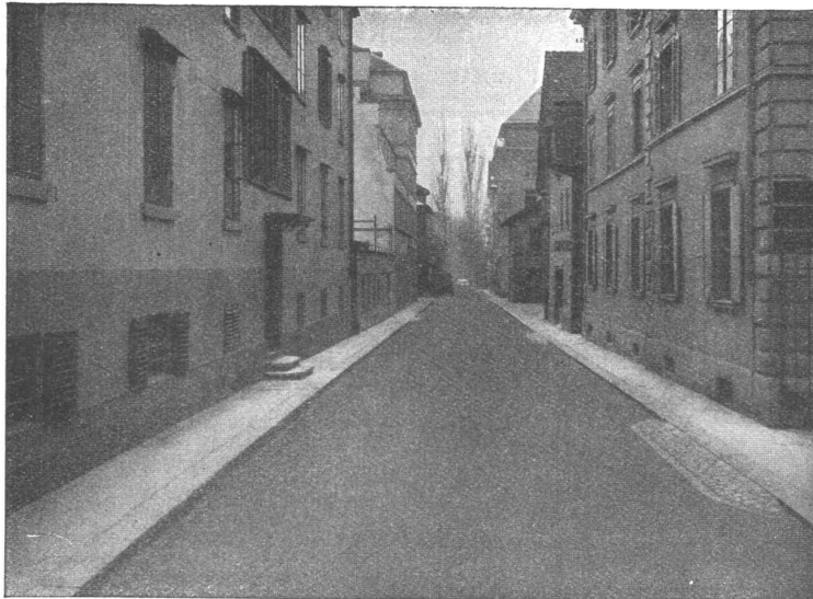
GLARNISCHSTRASSE ZÜRICH Walz-Asphalt: Topeka, 6 cm stark
