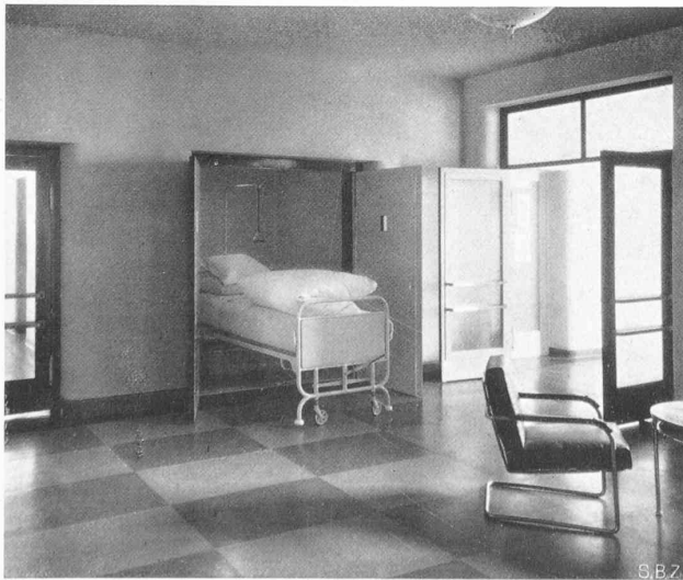
Abb. 10. Interne Verkehrshalle mit Bettenaufzug.
