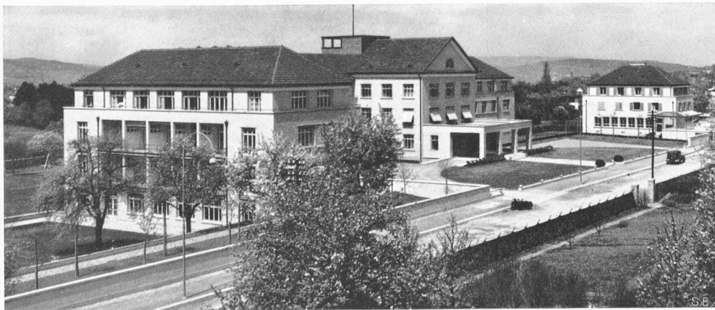
Abb. 3. Gesamtbild der „Privatklinik Hirslanden“ in Zürich, aus Osten, von der Anfahrseite; rechts das Dienstgebäude.
