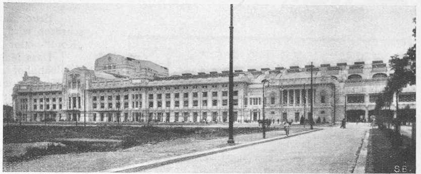
Abb. 5. Oestlicher Flügelbau, Unterführung der Via Pergolesi (rechts).
