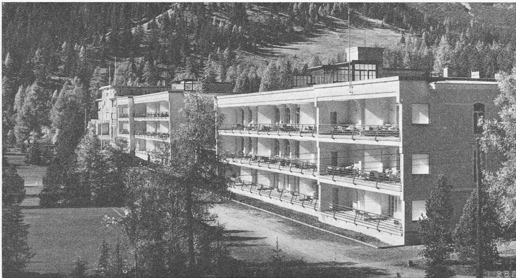
Abb. 15. Gesamtansicht aus Südosten mit den vorgebauten Liegeterrassen. (Ein verbindender Mittelbau ist projektiert.)
