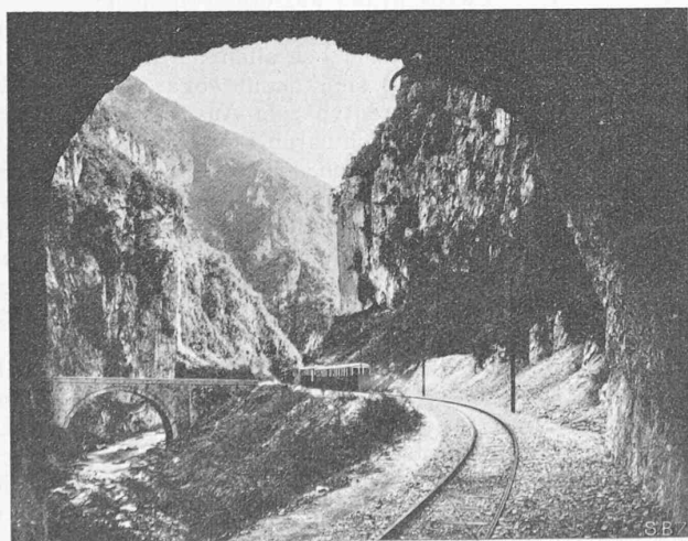
Abb. 16. Blick auf Balza tagliata vom oberen Portal des Tunnels gleichen Namens aus gesehen (Km. 35) am Corno-Fluss (taleinwärts).
