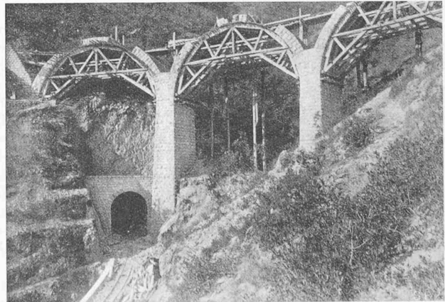
Abb. 26. Viadukt von Tassinare (drei Öffnungen zu je 15 m). Gewölbemauerung auf hölzernem Lehrgerüst.
