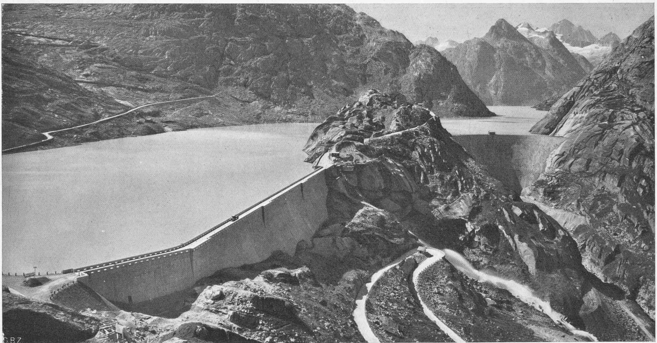
Abb. 2. Gesamtbild aus Nordost über Seufereggmauer, Nollen, Spitalamm-Mauer und Grimsel-Stausee. Rechts im Hintergrund das Finsteraarhorn.
