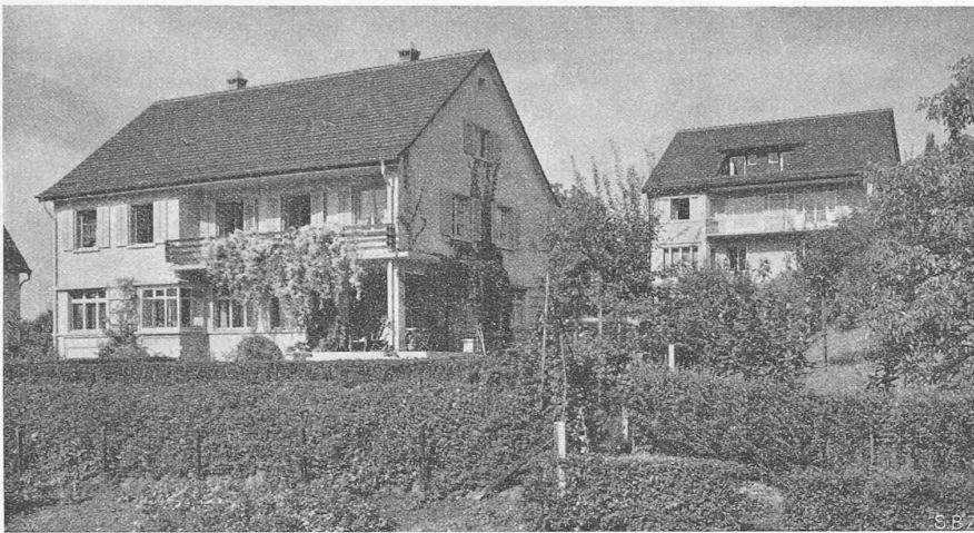
Abb. 6. Haus Stiefel (links vorn) und Haus Wegelin (rechts hinten), aus Südosten gesehen.
