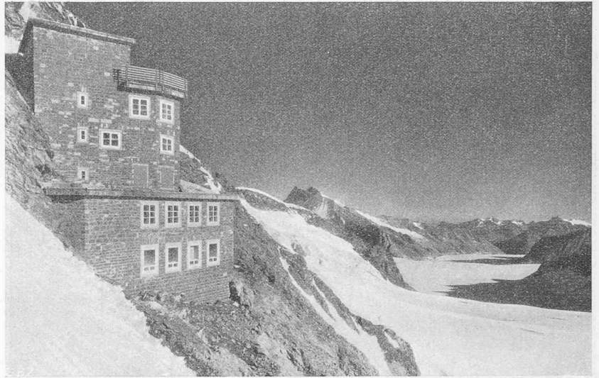
Abb. 2. Forschungshaus mit Blick nach SO über Concordiaplatz auf den Aletschgletscher.
