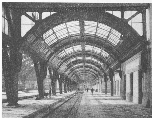
Abb. 19. Innerer, eingleisiger Teil einer Seitenhalle.
