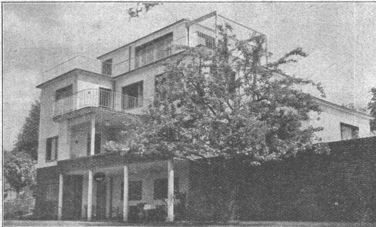
Villa mit Flachdach in Goldbach-Zürich. Entwurf: Alex. Bosshard, Architekt, Brüssel; Bauleitender Architekt: FRANZ SCHÜPBACH, Zürich.
