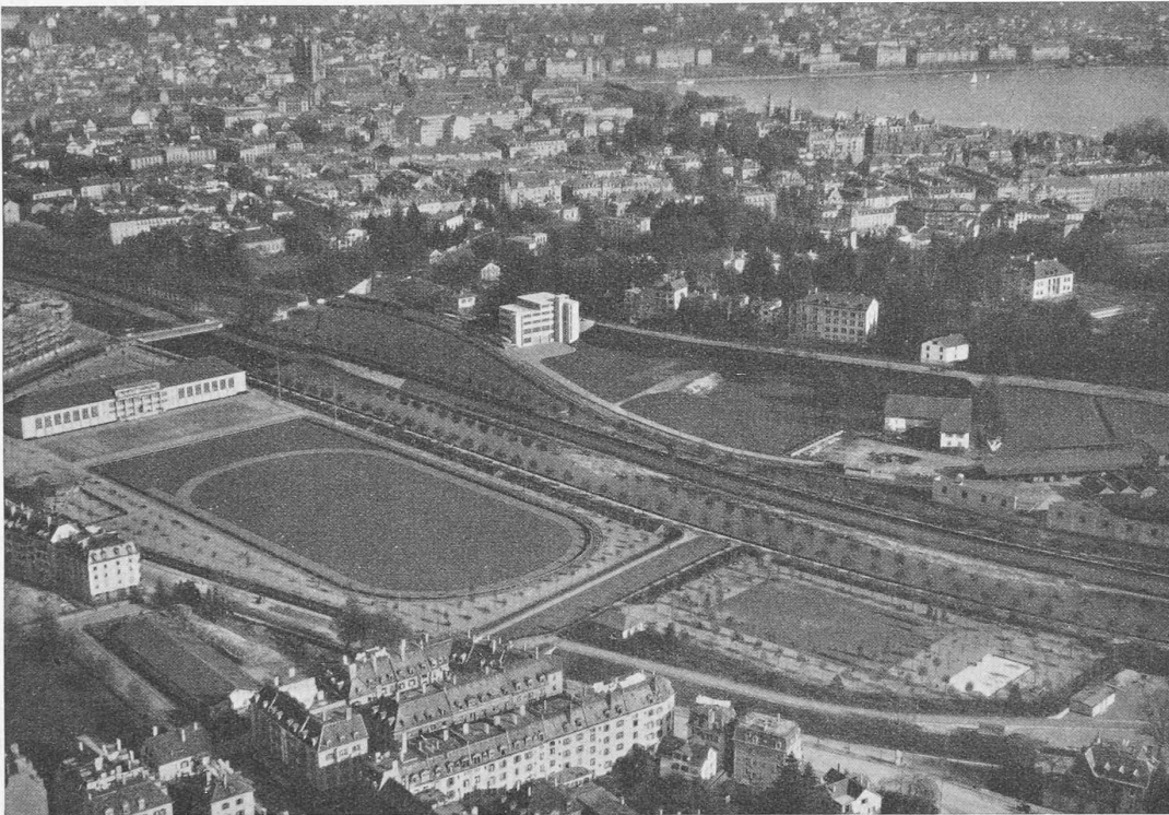
Abb. 1. „Ad Astra-Aero“-Fliegerbild aus Westen auf die neuen Sport- und Grünanlagen „Sihlhölzli“ in Zürich. Links Turnhallengebäude (jenseits der Sihl das „Eglisana“-Lagerhaus, vergl. „S. B. Z.“ 28. Nov. 1931), rechts Kinderspielplatz.
