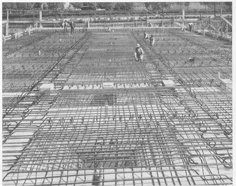
Abb. 21. Pilzdecken-Armierung über der Turnhalle C (Boden von Halle B). — Ing. R. Maillart.
