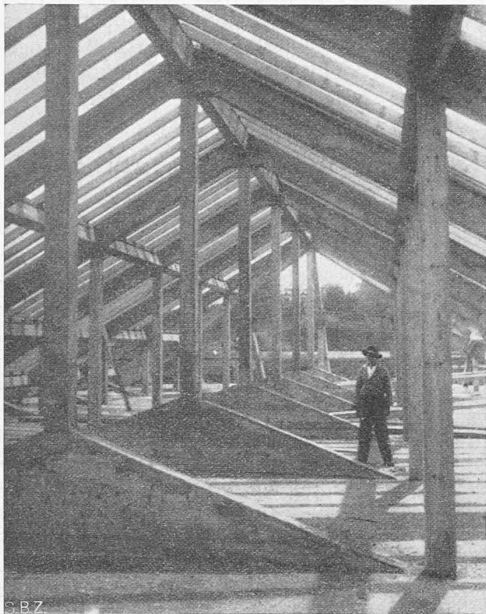
Abb. 18. Blick in den Eisenbeton-Dachstuhl mit hölzerner Sparrenlage. — Ing. R. Maillart, Zürich-Genf.
