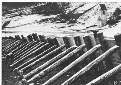
Abb. 6 und 7. Schutzdamm, im Nov. 1932 mit Holz erhöht, Links Turm der alten kath. Kirche (Nov. 1932).
