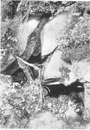
Abb. 13. Zerrissenes Gestein nahe unterhalb Punkt R (oberer Teil).
