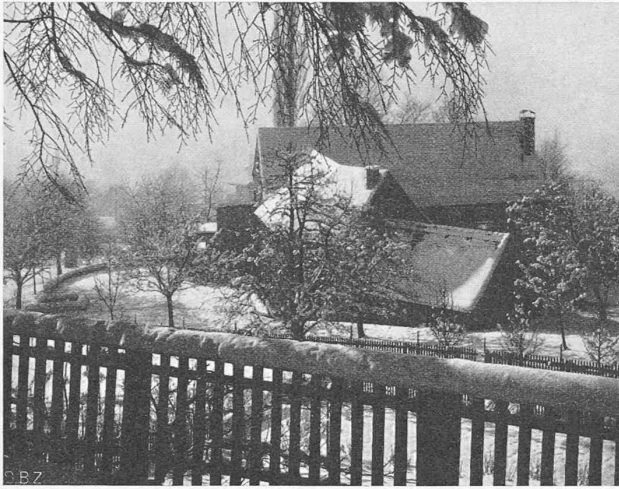
Abb. 2. Ansicht von der Bergseite, aus Norden.
