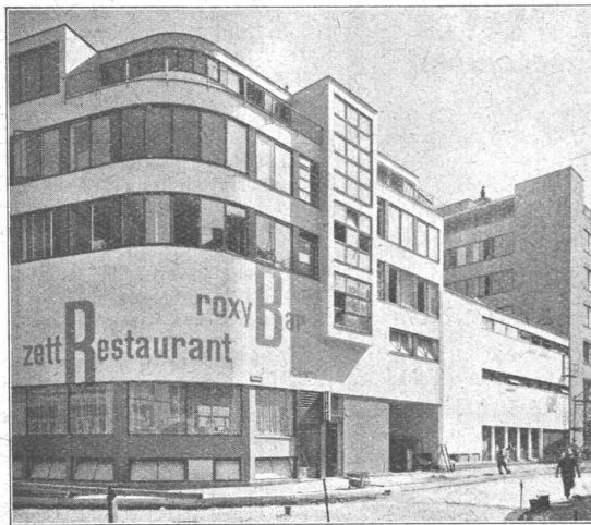
ZET-HAUS in Zürich Architekten: HUBACHER & STEIGER
