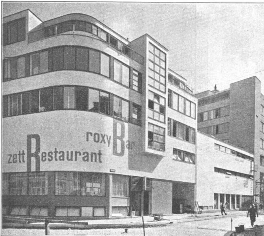
ZET-HAUS in Zürich Architekten: HUBACHER & STEIGER
