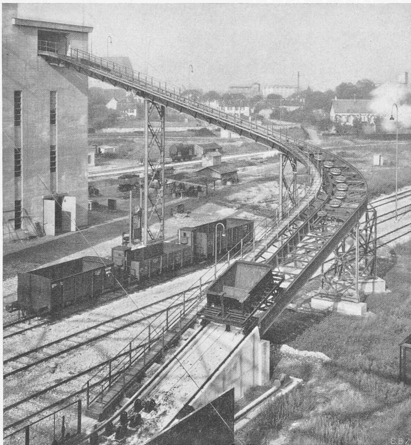
Abb. 1. Gesamtbild der Rohkohlen-Förderbrücke.
