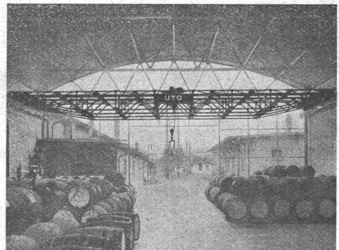
3 Motoren-Laufkran für Lagerschuppen.
