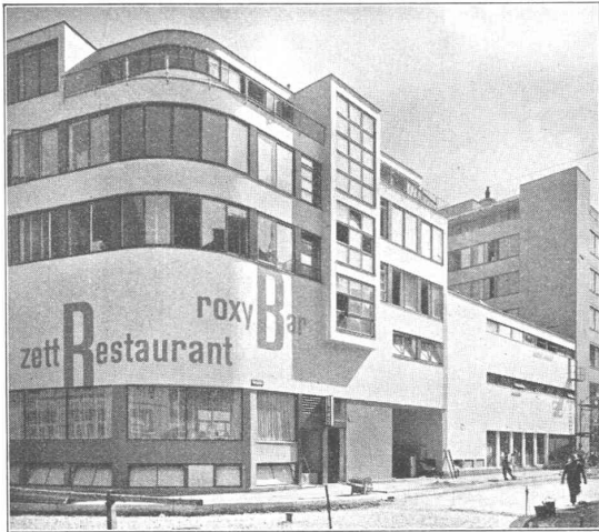
ZETT-HAUS in Zürich Architekten: HUBACHER & STEIGER
