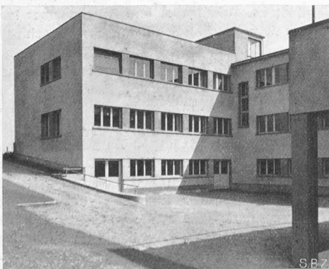
Abb. 5. Hauptbau, Wirtschaftshof aus Norden.
