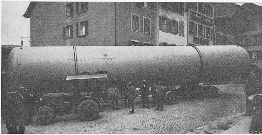
Abb. 6. Transport eines Hochdruck-Speicherkessels von 17,5 m Länge und 3 m Ø durch die Stadt Aarau.
