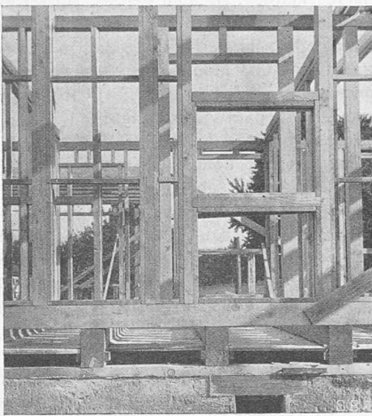
Abb. 6. Holzfachwerk mit Sprossen für Ondulexplatten.
