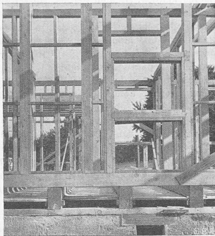
Abb. 6. Holzfachwerk mit Sprossen für Ondulexplatten.
