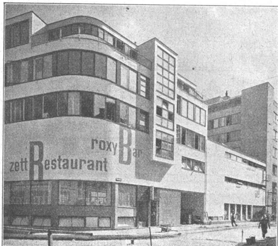
ZETT-HAUS in Zürich Architekten: HUBACHER & STEIGER
