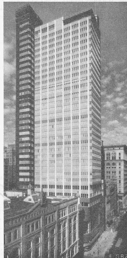
Abb. 1. P. S. F. S.-Building, Seitenansicht.
