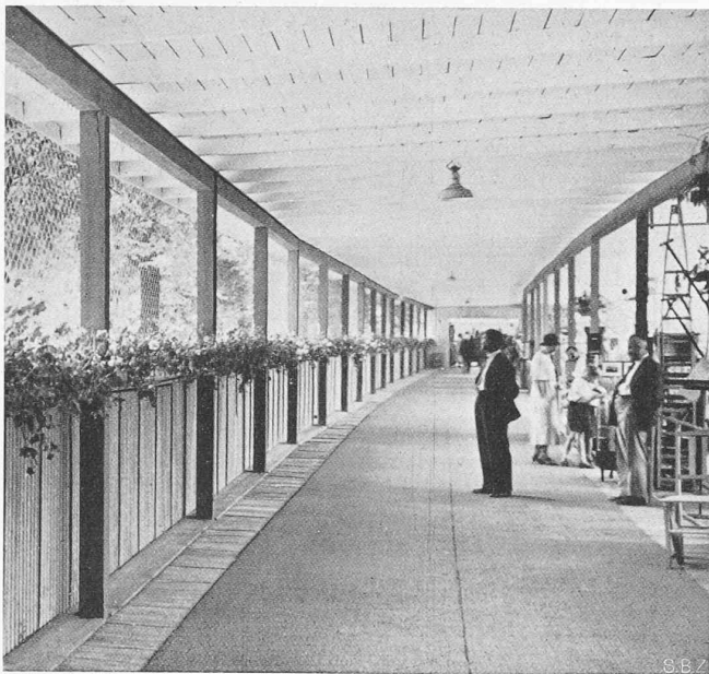
Abb. 16. Laubengang. Links nur durch Drahtgeflecht abgeschlossene Öffnungen.
