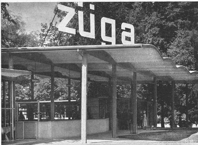
Abb. 5. Eingang; grosses, unabhängiges Dach über alle Einzelbauten.
